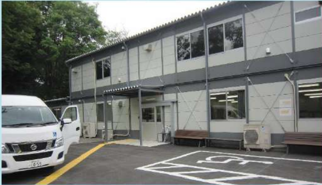
仮設管理棟外観
